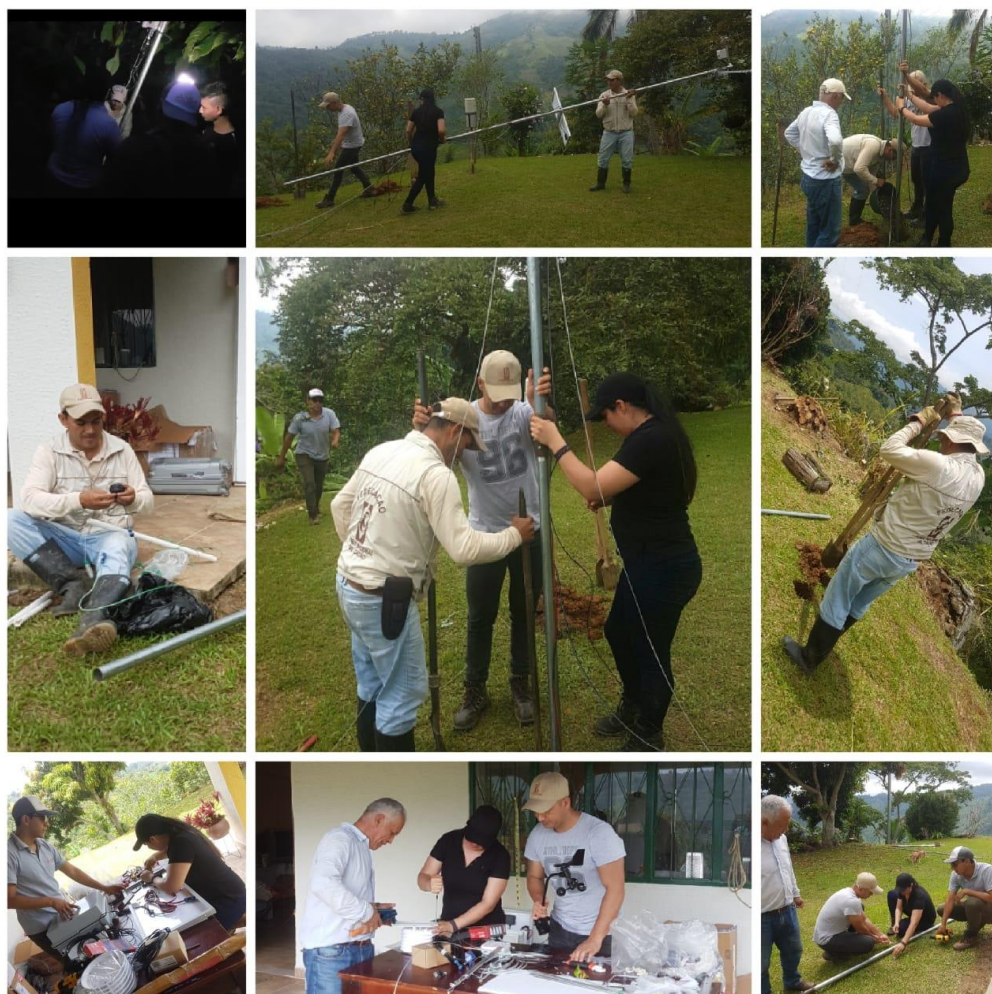
Imagen 13 Instalación de equipos proyecto “Digitalizando la producción de cacao en Colombia” Rionegro-Santander.
